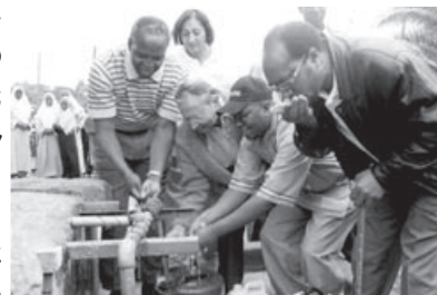
ナイロビ・ロータリー・クラブ会員がリルタ村立学校の新しい水道を検査するのを見つめる生徒たち。
