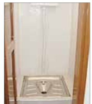
マプト・ロータリー・クラブ(モザンビーク)とスカナボー・ロータリー・クラブ(デンマーク)の協力による、グローバル補助金を利用した給水/衛生設備設置プロジェクト。
